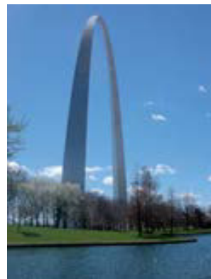
*Gateway Arch de San Luis (Missouri): Ejemplo de la curva catenaria en la arquitectura
